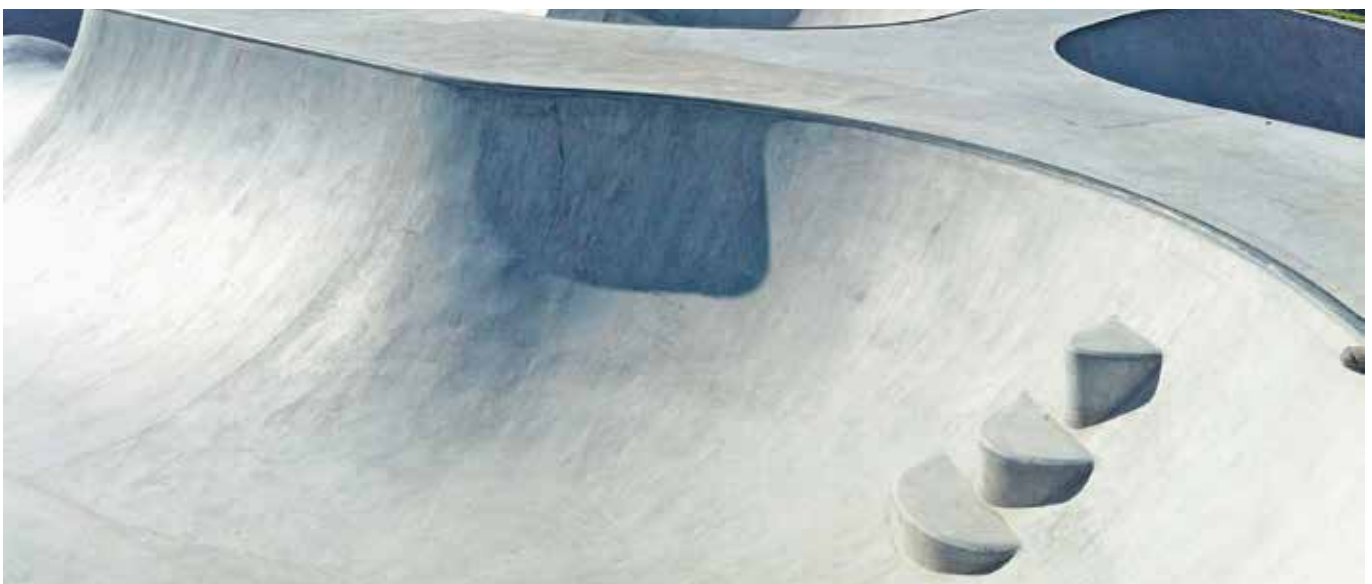
Einstiegsmöglichkeit in Form einer Treppe
