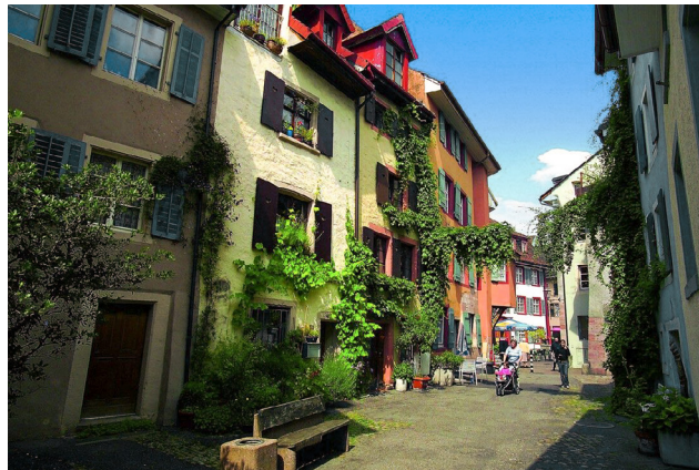
Begrünte Fassaden schaffen eine angenehme Atmosphäre und fördern durch Beschattung und Verdunstung ein gutes Lokalklima. (© Henri Leuzinger, Rheinfelden)
